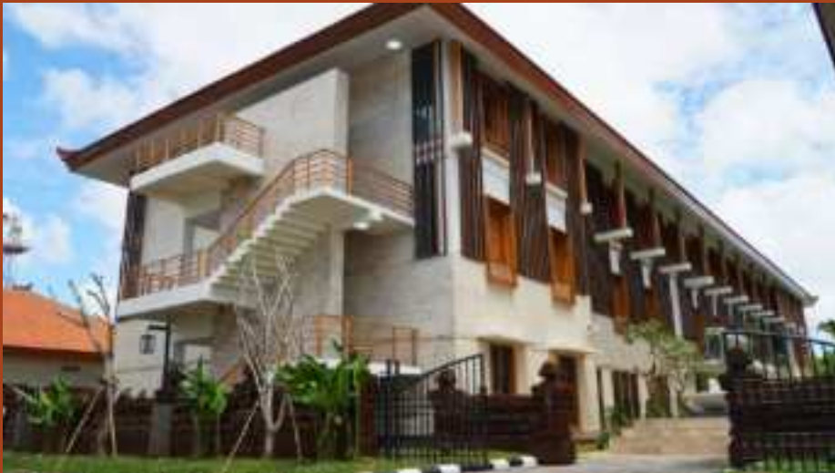
Gedung Asrama Diklat 2
