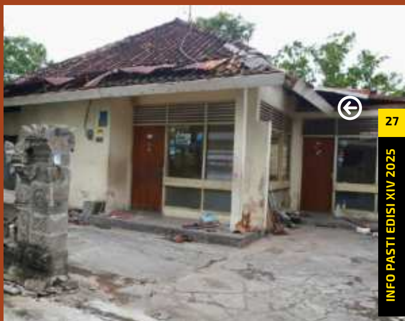
foto : kondisi perumahan kompleks Renon sebelum dilakukan penataan kawasan
