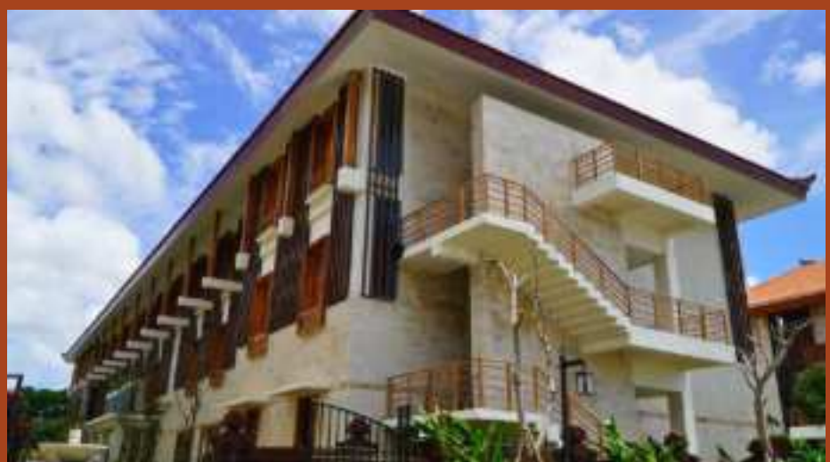
Gedung Asrama Diklat 1
